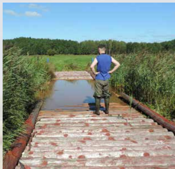
Jeden z dwóch brodów o drewnianej konstrukcji / one of two wooden fords
