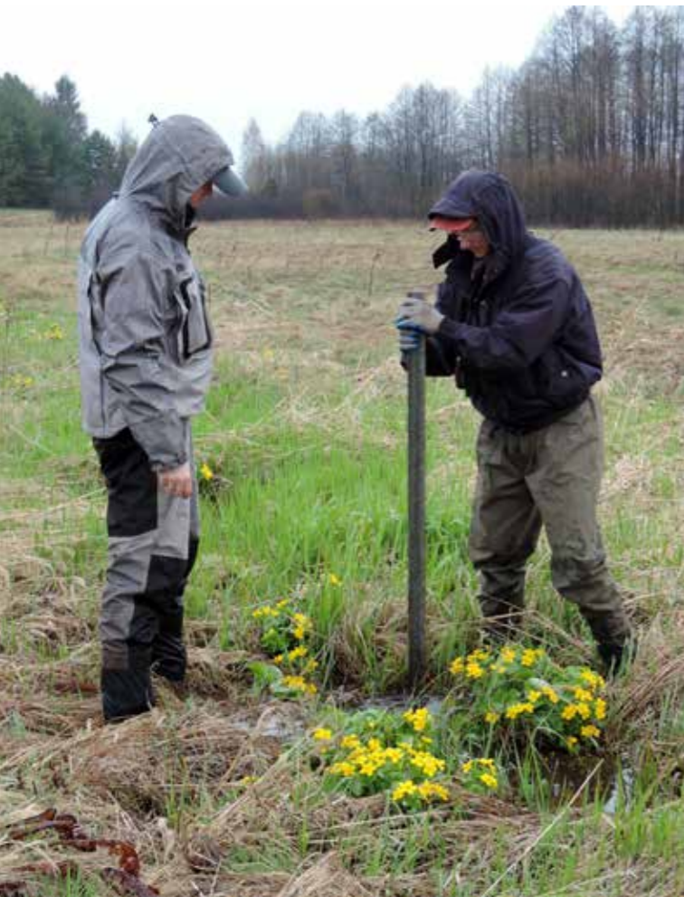
Montaż piezometrów/ Installation of piezometers
