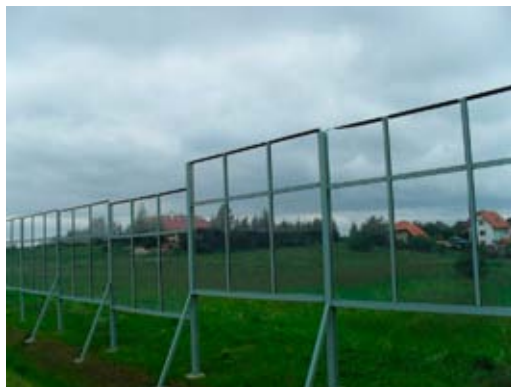
Przezroczyste ekrany akustyczne w okolicach Olsztyna, fot. Adam Zbyryt
