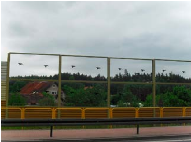
Przykład nieprawidłowych zabezpieczeń przed kolizjami zastosowanych na ekranach akustycznych, fot. Adam Zbyryt
