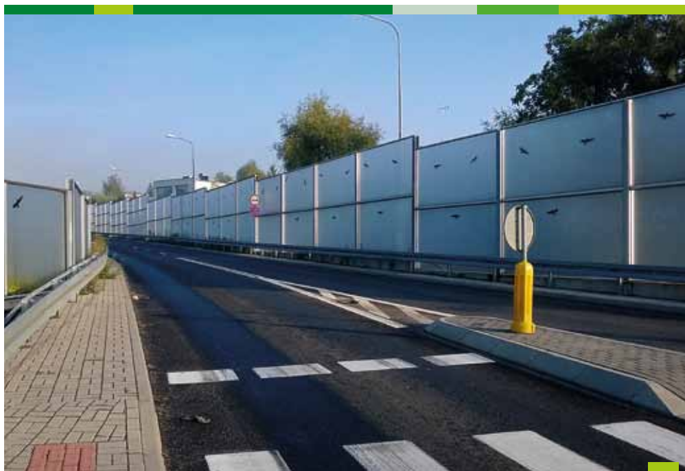
Ryc. 42. Miejskie drogi są bardzo dużym zagrożeniem dla ptaków. Zagrożenie to zwiększają źle zaprojektowane ekrany akustyczne (fot. M. Bocheński)
