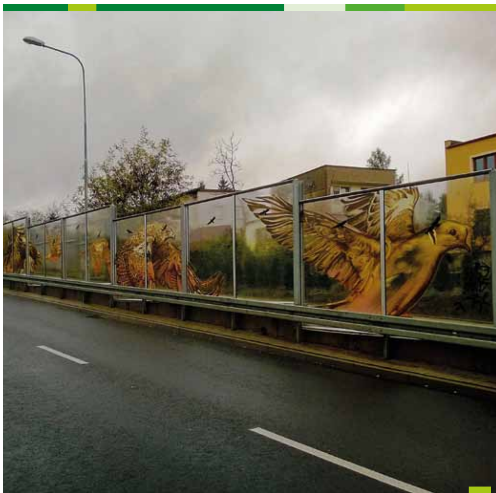
Ryc. 61. Ciekawie zaprojektowane (i uzgodnione z odpowiednimi służbami miejskimi) graffiti może skutecznie ograniczać kolizje ptaków z ekranami akustycznymi. (fot. M. Bocheński)
