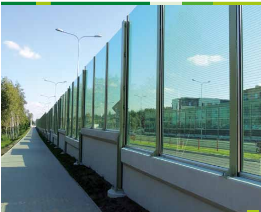
Ryc. 60. Czarne wąskie pasy o szer. ok. 2 mm, oddalone od siebie o ok 30 mm minimalizują efekt „lustra” (fot. A. Zbyryt)
